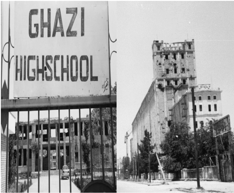
تصویر ۷۲: از چپ: ساختمان بزرگ و ویرانه سیلو در کابل | دایرستان / لیسه غازی، کابل - ۱۳۸۲ خورشیدی
